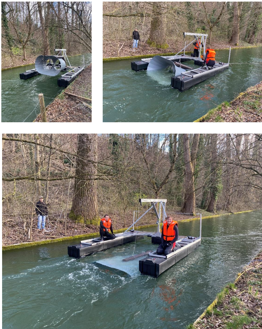
Abbildung 2: Der Energyfish kann innerhalb weniger Stunden installiert und in Betrieb genommen werden.
